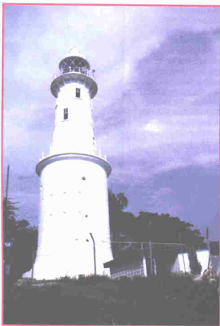
Rumah api Kuala Selngor yang terletak di atas Bukit Malawati.
