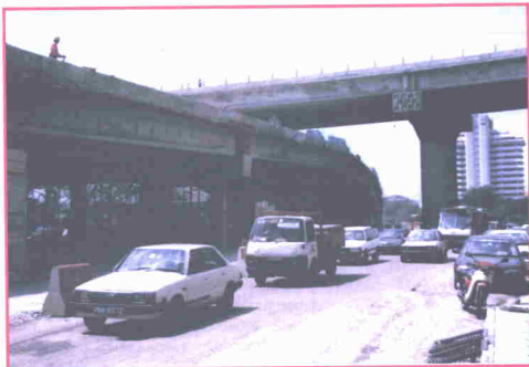
Kawasan ini pernah diterokai oleh pelombong Melayu yang bernama Abdul Rani Bilal. Di persimpangan yang sibuk ini, teknik pembinaan yang disebut teknik sosrohabu digunakan untuk membina jejantas bagi mengurangkan masalah kesesakan lalu lintas yang menjadi beban kepada warga kota.
